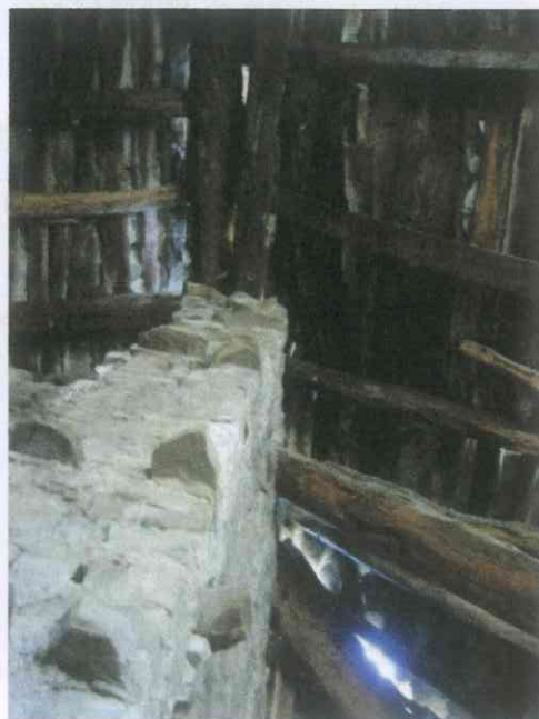
15. intradosso della copertura
