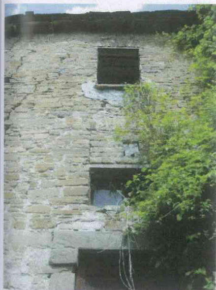
6. dettaglio facciata est
