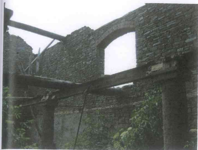
22. muro sud (lato portico) visto dall'interno
