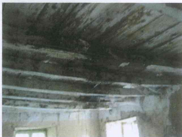
13. intradosso solaio al piano primo
