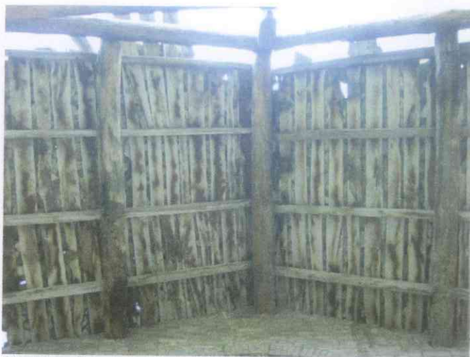
23. intradosso porzione di copertura
