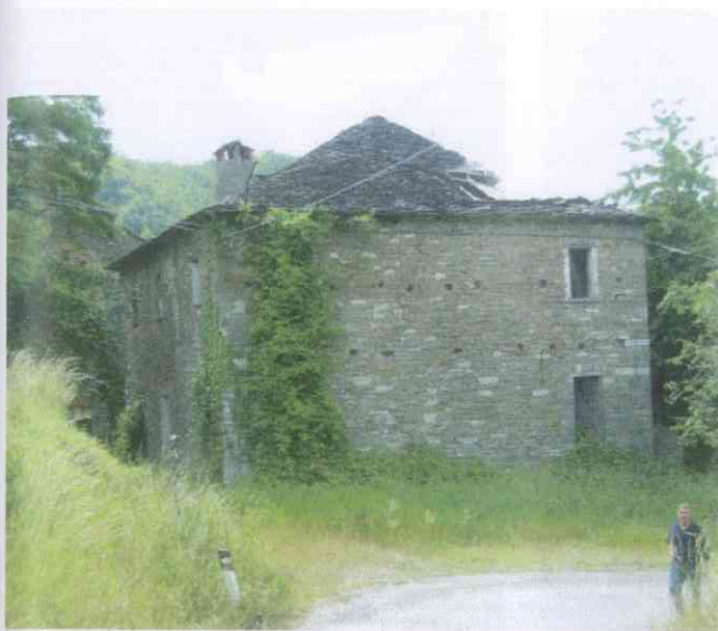
4. facciata ovest fabbricato abitativo
