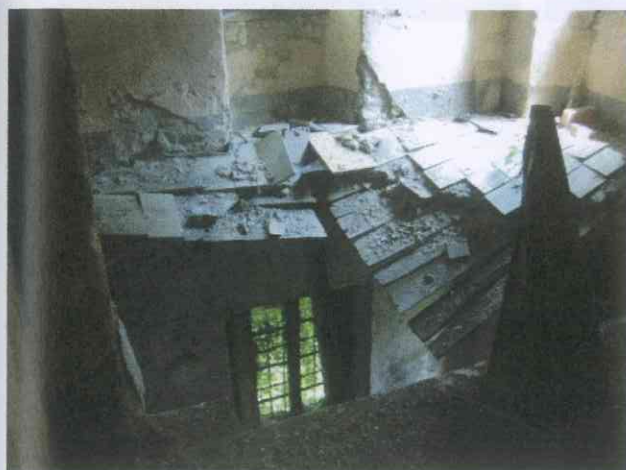
12. pavimento al piano primo
